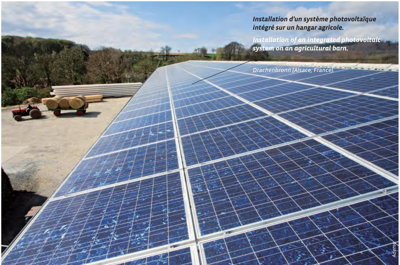
**Installation d'un système photovoltaïque intégré sur un hangar agricole.**
