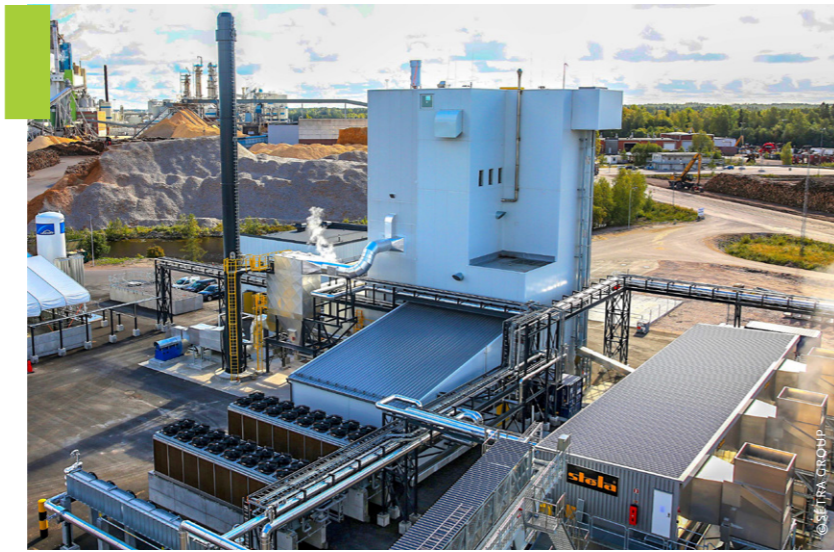
Usine de production de biocarburant de deuxième génération par pyrolyse rapide de la biomasse (Fast Pyrolysis Bio-Oil ou FPBO) située à Gävle en Suède.
