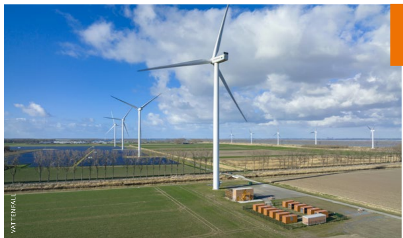
Vattenfall a inauguré le 23 mars 2022 l'Energy Park Haringvliet, une centrale hybride combinant les technologies éoliennes et solaires couplées à des batteries aux Pays-Bas
