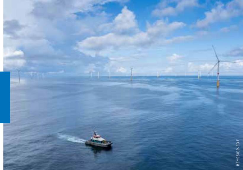
Le parc éolien de Saint-Nazaire (480 MW) est entièrement opérationnel depuis le 23 novembre 2022. Il est le premier parc éolien offshore commercial français, équipé de 80 turbines General Electric de type GE Haliade 160-6 MW.
